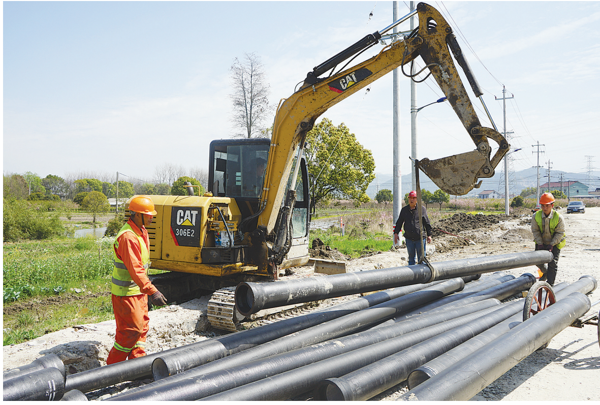
图为3月28日七里浦水厂管网延伸兼兰江街道笔竹村村级供水站工程施工现场。 记者 陆燕娜 通讯员 黄珊摄
